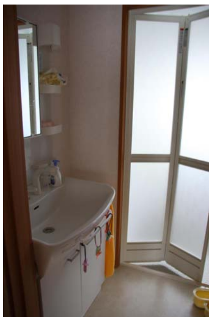
洗面所（改修予定）
