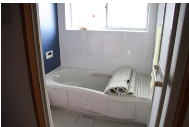
風呂場（リフター設備など改修予定）
