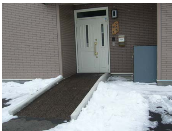
玄関スロープ
